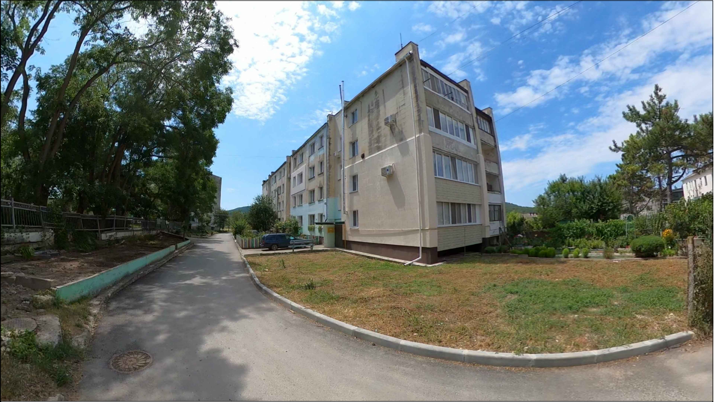
Вид на площадку благоустройства со стороны въезда с ул. Ленина.
